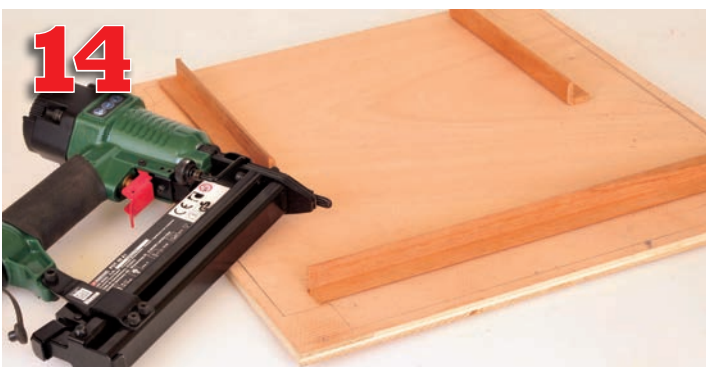
Placer une cornière servant de butée à l'arrière du plat.
